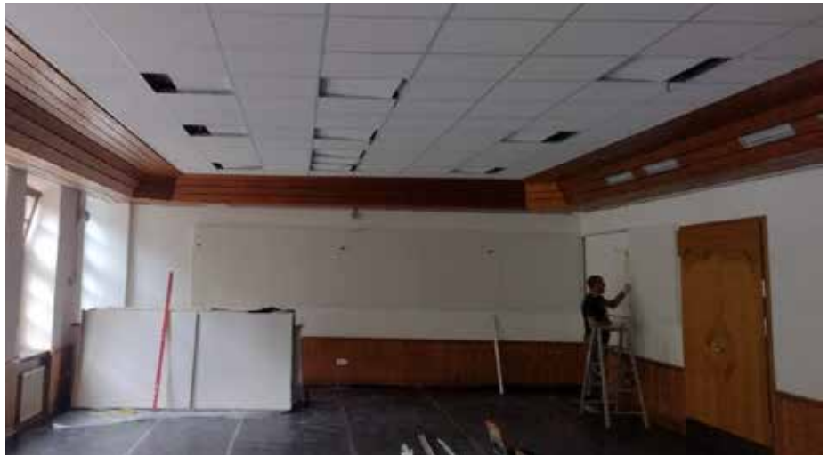
Zeitgemäßer Schallschutz an der Decke und den Wänden des Speiseraums sorgen nun für eine ruhigere Atmosphäre beim Essen
