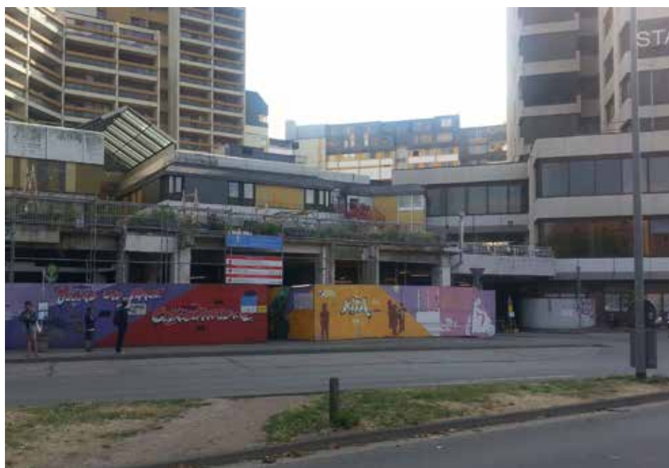
Zugang vom Küchengarten © Hans Mönninghoff
