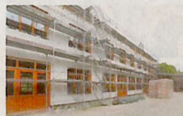
Das Gebäude von außen. Einst war es eine Garage für Militärfahrzeuge.
