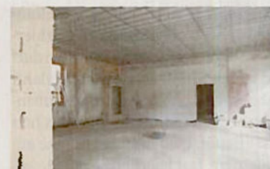
Die Werkstätten erhalten Holzdielen, das Mauerwerk bleibt sichtbar.
